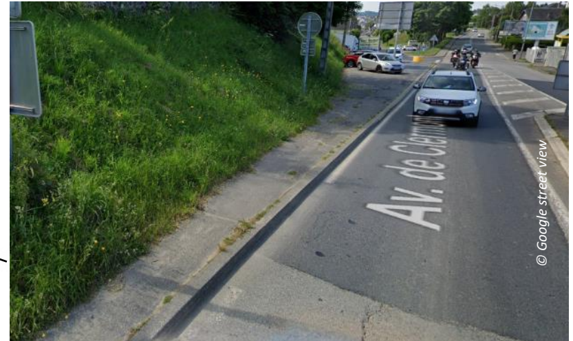
Pincement et absence de passages piétons à l'intersection de l'impasse Jean Jaurès.
