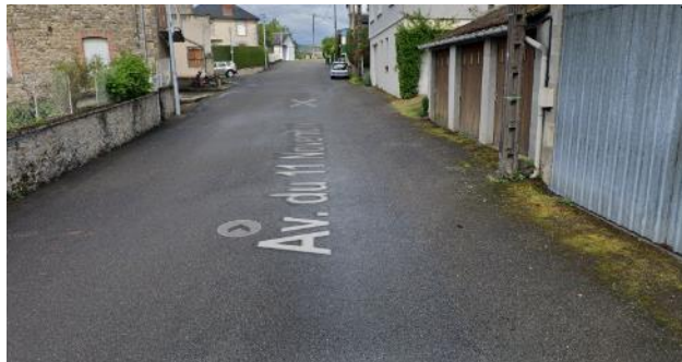
Absence de trottoirs.
