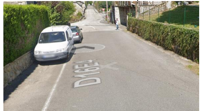
Signalétique au sol peu clair et effacé.
