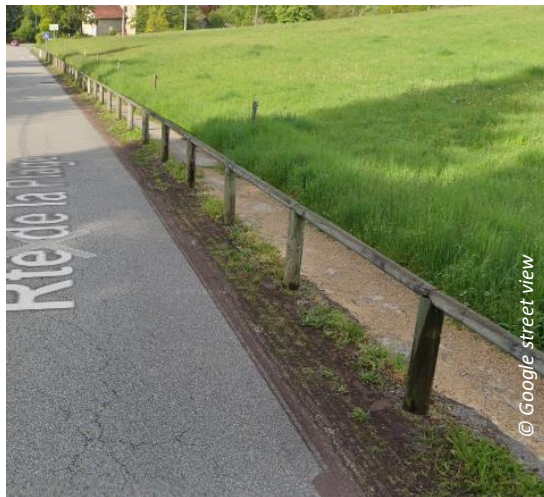
Cheminement piétons route de la plage.
