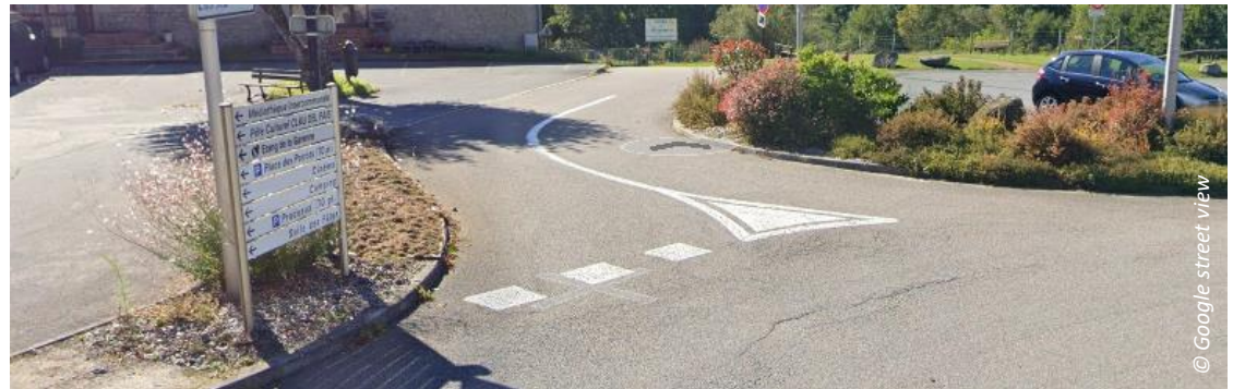
Le piéton doit contourner les massifs ou passer sur la chaussée pour rejoindre le point de tri de la route des Buiges.
