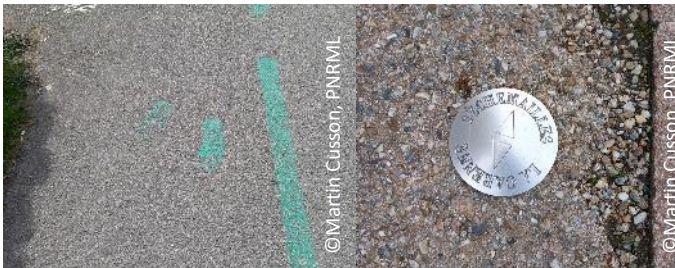
Marquage au sol effacé.
