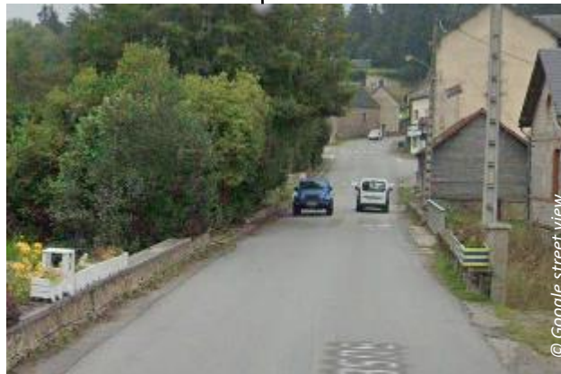
Deux véhiculent se croisent sans espace pour les piétons sur ce pont.
