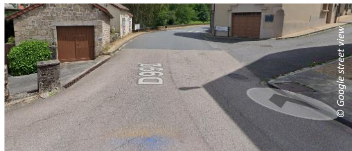
Rupture dans un tournant de part et d'autre du pont (visibilité).
