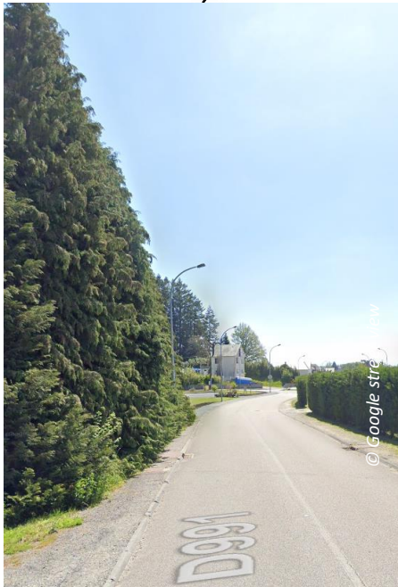
Végétation débordant sur cheminement
