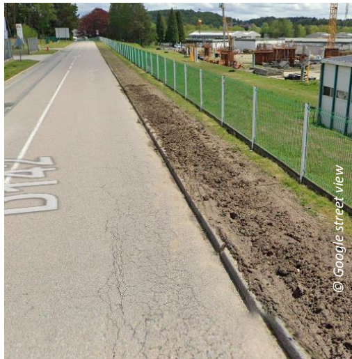
Trottoir à créer
