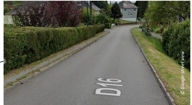
Rupture cheminement (végétation qui déborde)
