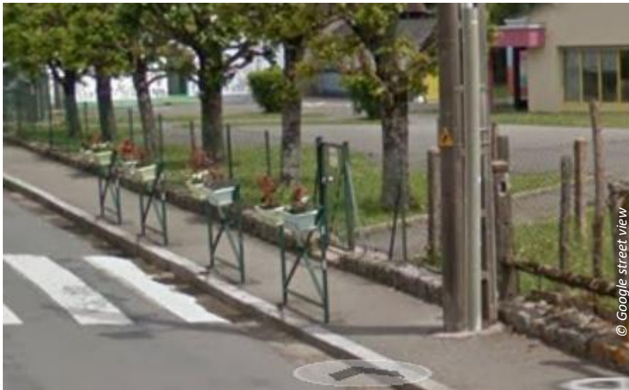
L'entrée de l'école maternelle reste assez étroite. Un poteau fait obstacle juste devant l'entrée et le passage piéton n'est pas aux normes PMR.
