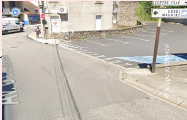
Rétrécissement du trottoir à l'entrée du parking.
