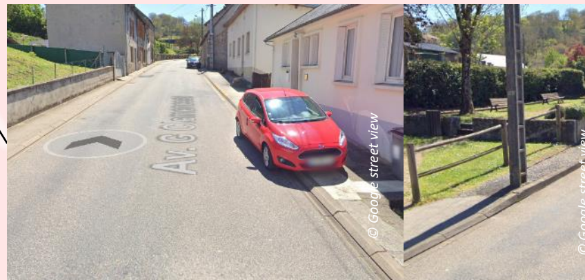
Stationnement à délimiter, présence d'obstacles.
