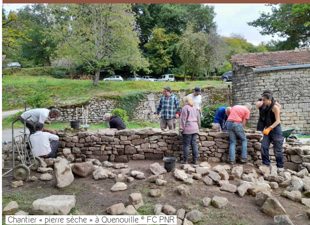
Chantier « pierre sèche » à Quenouille ° FC PNR
